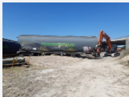
SAINT HILAIRE RACCORDEMENT LGV PASSAGE DE TRAIN DE FRET, 2 SEMAINES DE TRAVAUX EN 2021
