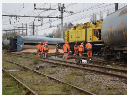
EN DÉCEMBRE 2022, IL A FALLU 6 JOURS POUR DÉGAGER UN TRAIN DE FRET COUCHÉ EN PLEINE VOIE SOUS CATÉNAIRE DANS UNE ZONE NON ACCESSIBLE PAR VOIE ROUTIÈRE SUR LA LIGNE PARIS LIMOGES TOULOUSE.
